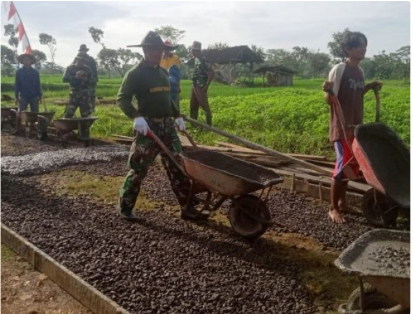
Babinsa sertu Jumali Babinsa Koramil 03/Kebakkramat dalam pengecoran Jalan di desa Jatiwarno Kec. Jatipuro Kab. Karanganyar. Sabtu, ( 14/5/22 )
